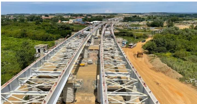
D1 0136 Říkovice - Přerov Výroba a montáž OK mostného objektu SO 209 – Estakáda v km 82,973 přes Bečvu a žel. trať Olomouc - Přerov
